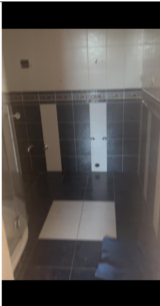
Общий санузел второго этажа
