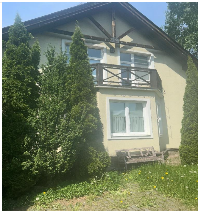
Вид фасада со стороны двора
