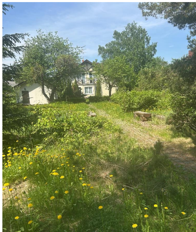
Вид фасада со стороны двора
