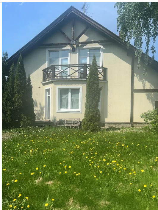
Вид фасада со стороны двора
